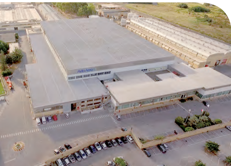
Vista dall'alto dello stabilimento di Brindisi.
